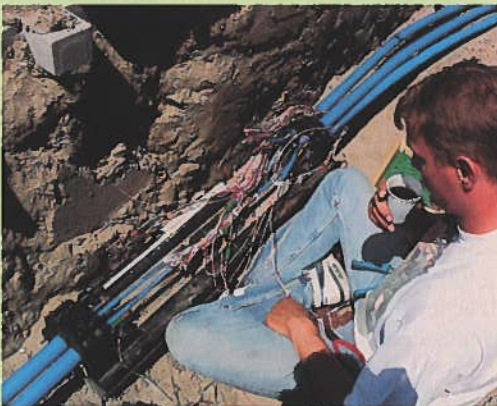
◀ Foto 9 De aanleg van Flashnet
